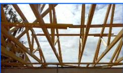
Die Dachkonstruktion besteht aus Nadelholz, Güterklasse II
