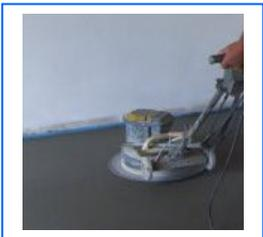
In den Wohngeschossen Ihres Planart Hauses wird ein **wärme- und schallisolierender Estrich** auf der erforderlichen Wärme- und Trittschalldämmung aufgebracht.
