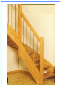
Die Geschosstreppen zum Kellergeschoss (sofern vereinbart) und zum Obergeschoss sind **offene versiegelte Massivholzwangentreppen, mit massiven Geländern und Handläufen, wahlweise in Buche und Kiefer.**
