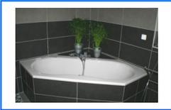
Im Standard enthalten ist die einfache Verlegeweise (Fuge/Fuge).
